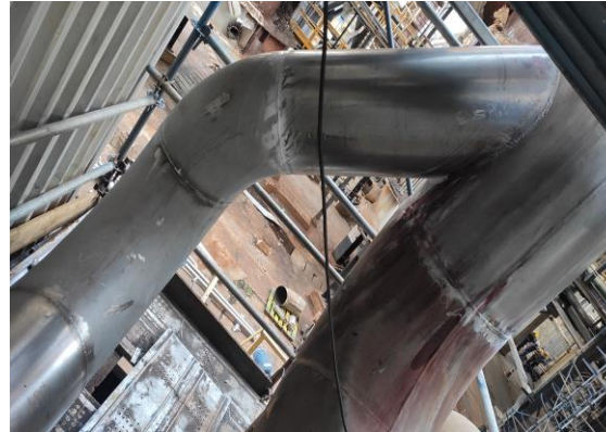
Fabricação e substituição de trecho de tubulação de 28" e de 18" da Evaporação B
