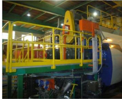
Retrofit e montagem de uma prensa de lavagem. (METSO/ CMPC Laja)
