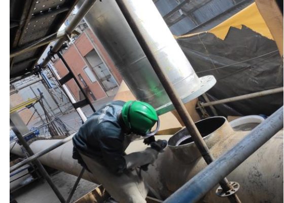
Substituição de válvula, Flange e Pestana Evaporação C
